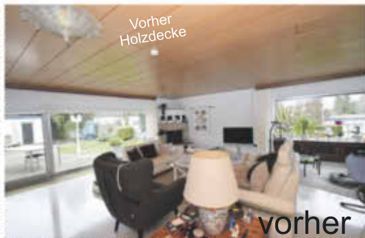
Vorher: Wohnzimmer Holzdecke. Die Paneelen wurden zur Höhengewinnung entfernt. Interessante Videos zu unseren Baustellen finden Sie unter www.schindera.com/video . Unserer Katalog finden Sie unter www.schindera.com/Katalog oder per Post anfordern!
