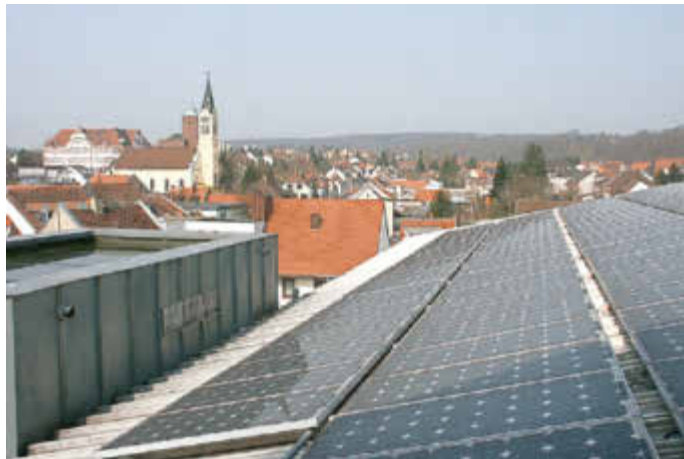
Dachlandschaften energetisch nutzen. Das neue Solarkataster informiert. Foto: Stadt St. Ingbert
