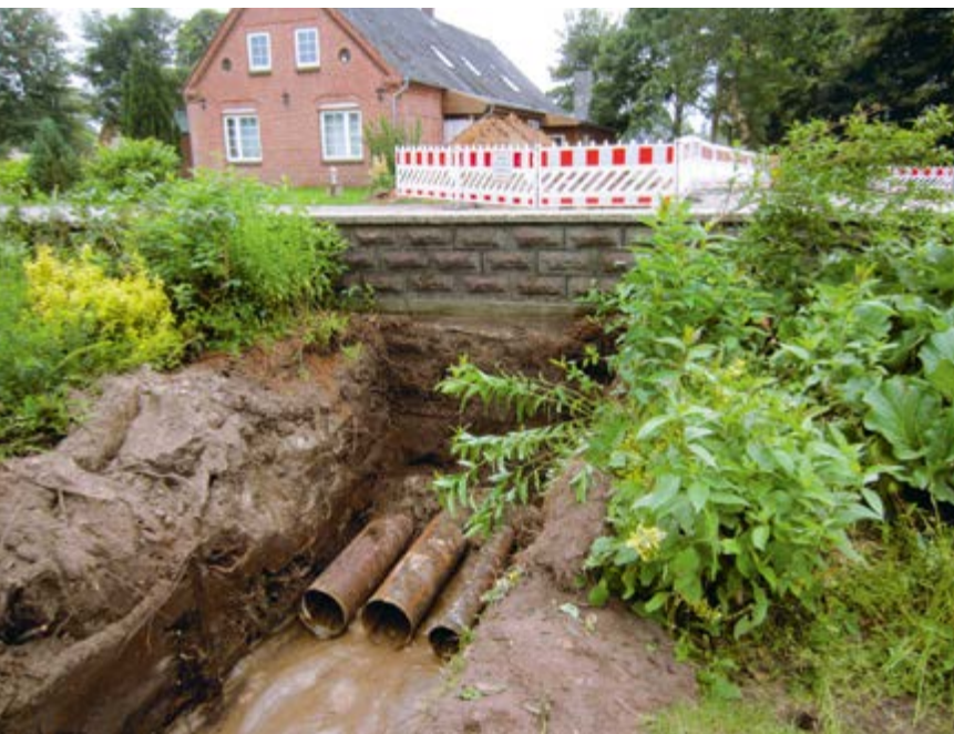
Vorbereitete Leerrohre für die Straßenunterquerung des Nahwärmenetzes
