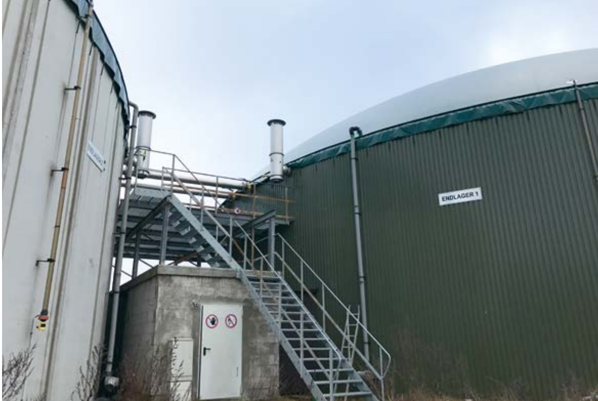
Fermenter der Biogasanlage des ortsansässigen Landwirts
