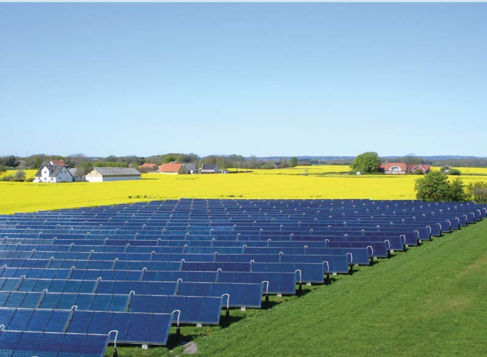
Solarthermie im Freiland mit Einbindung in ein Nah- und Fernwärmenetz
