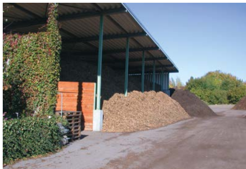
Hackschnitzel-Zwischenlager auf dem Kompostplatz, Stuttgart
