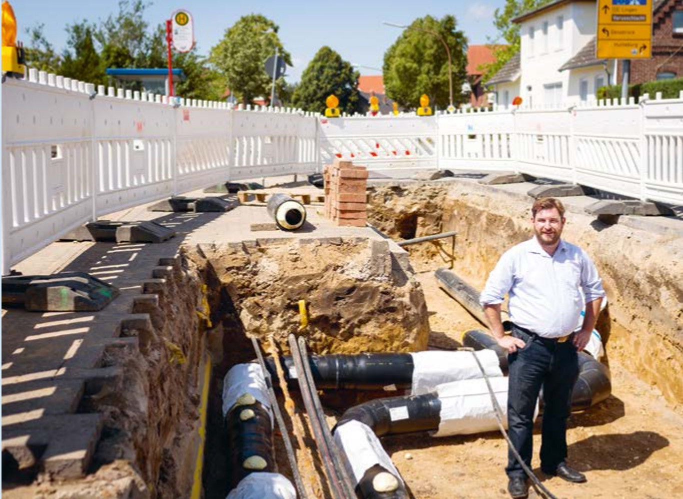
Der Geschäftsführer des auskoppelnden Industriebetriebs Christian Meyer zu Venne auf der Baustelle des Wärmenetzes in Venne, Ostercappeln
