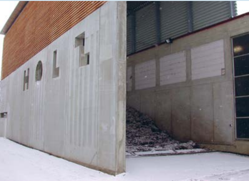
Befahrbarer, oberirdischer Brennstoffbunker, Stuttgart
