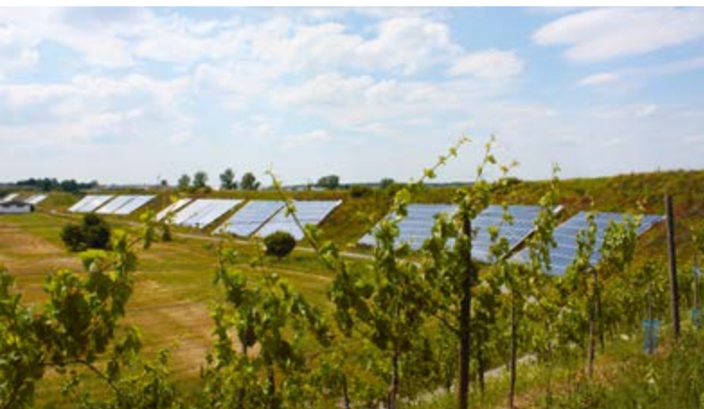
Difu-Exkursion im Sommer 2014 zum Crailsheimer Solarwärmenetz mit saisonalem Erdsondenwärmespeicher für das Quartier Hirtenwiesen II
