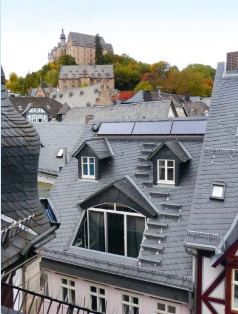
Solarwärmanlage in der Marburger Marktgasse
