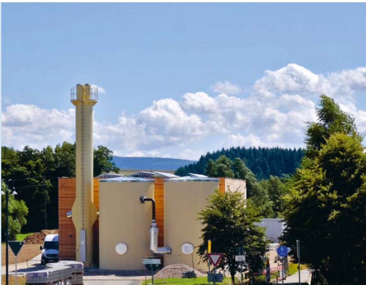
Außenansicht des Heizwerks Neuerkirch-Külz
