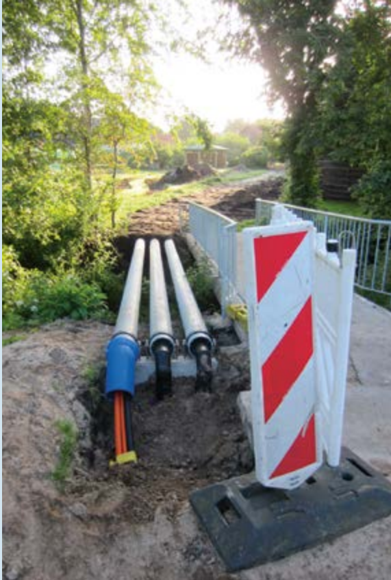
Bachüberquerung von Nahwärme- und Glasfasernetz
