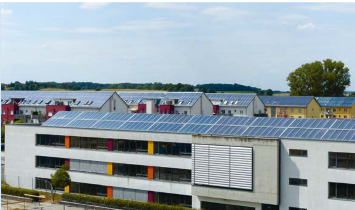
Dachintegrierte Kollektorfelder der solaren Nahwärme Crailsheim Hirtenwiesen 2
