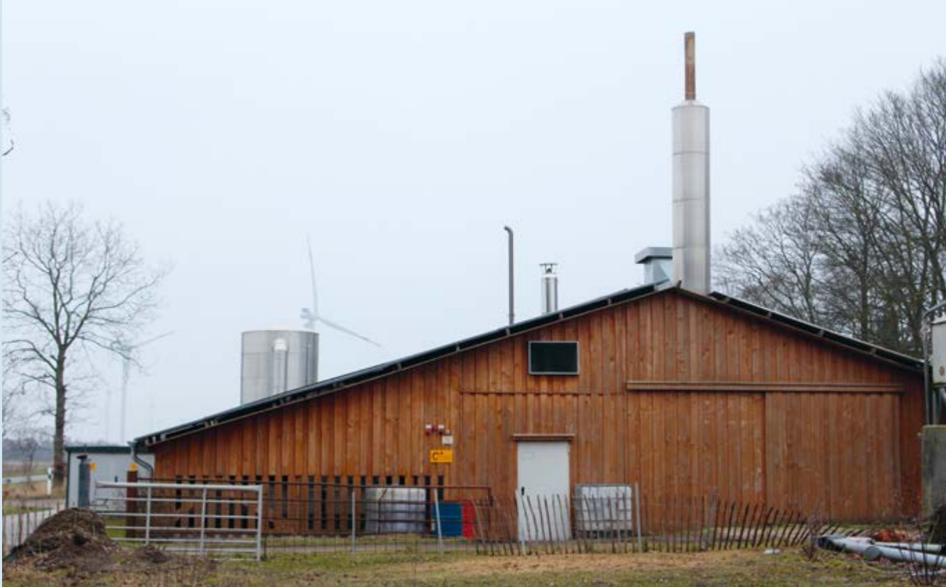
Das Gebäude der Heizzentrale in Sprakebüll
