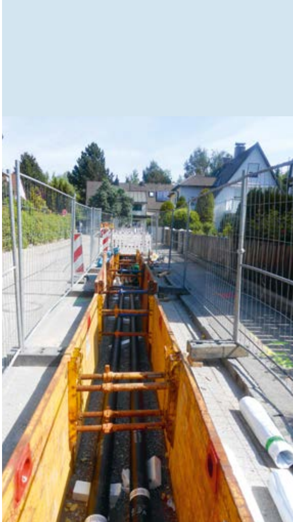
Leitungsverlegung für ein neues Nahwärmenetz
