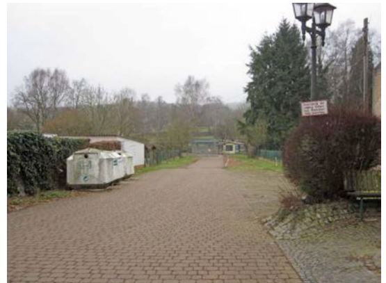
Zufahrt/Zugang Naturfreibad von der Goethestraße aus
