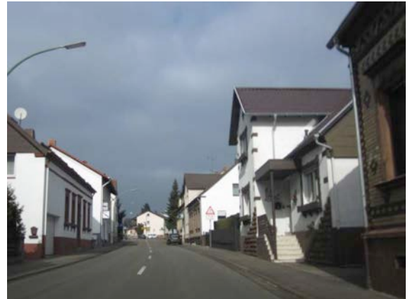
Ortsdurchfahrt: schmale Gehwege, fehlende Begrünung, keine Parkmöglichkeiten
