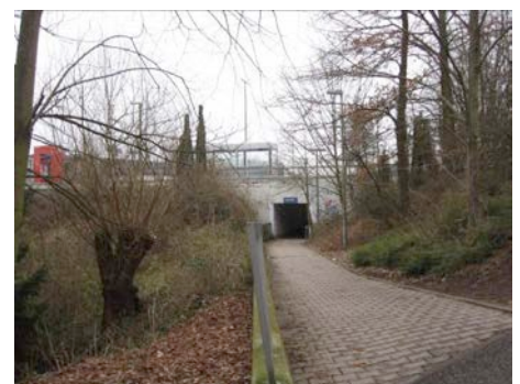
Unterführung zum Bahnhof
