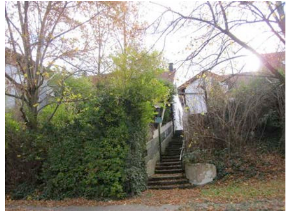
Treppe mit Gestaltungsbedarf im Einmündungsbereich Erbacher Straße
