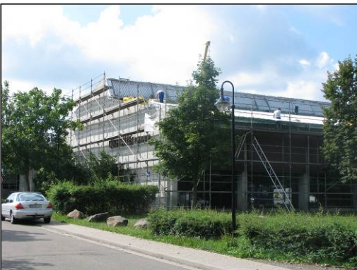
Abb. 76: Sanierung der Mehrzweckhalle „Dorfhalle“ in Limbach (ARGUS CONCEPT)
