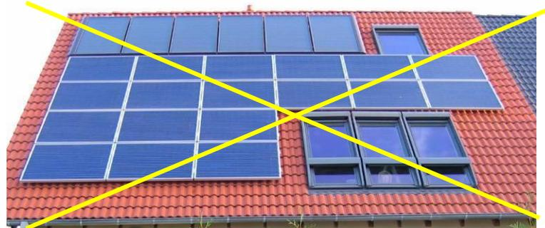
Abbildung 2-44: Nicht empfehlenswerte Anordnung einer PV-Anlage auf dem Dach (Stadt-Land-plus 2018)
