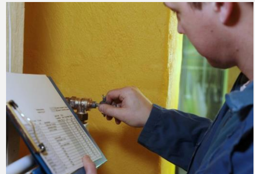
Foto: hydraulischer Abgleich, www.CO2online.de
