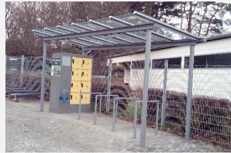
Überdachte Abstellanlage mit Schließfächern (Eigene Aufnahme)
