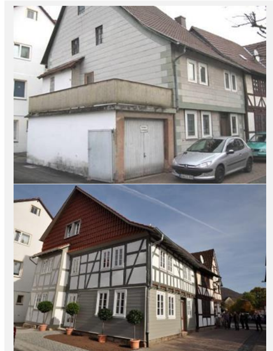
Musterhaus Wanfried vor und nach der Sanierung
